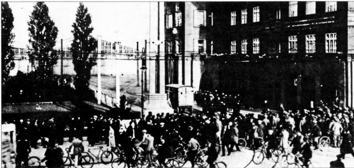
Vor dem BVG-Strassenbahn-Depot in der Müllerstraße.
